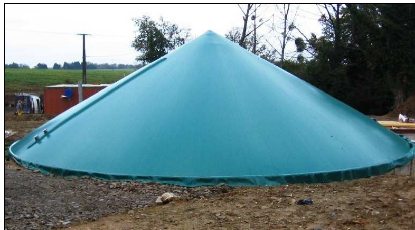
Exemple de gazomètre double membrane
