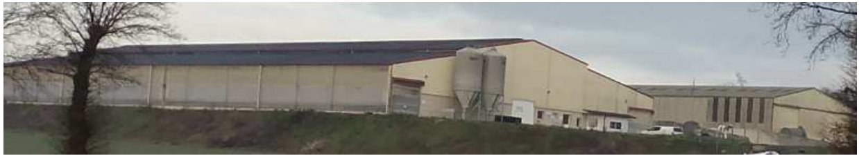
Vue Sud des bâtiments d'élevage bovin laitier
