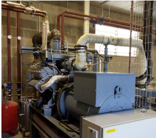
Cogénérateur avec son armoire de contrôle
